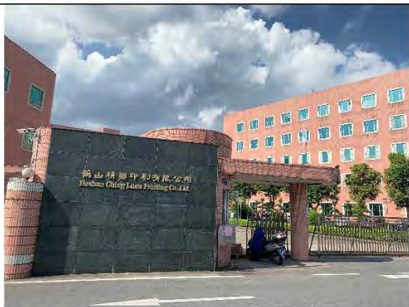
项目西面、北面：鹤山市精联印刷有限公司
